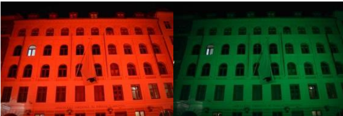
Forsamlingsbygningen: Arbejdernes Forenings- og Forsamlingsbygningens facade og tag er nu færdigrenoveret. På Kulturnatten var facaden oplyst med støtte fra Kulturnattens Lyspulje.
